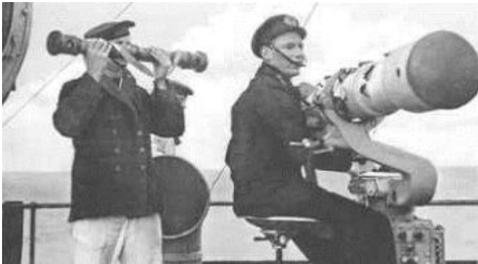
Foto 1 Vuurleiding, bediening van de afstandsmeter op een schip
